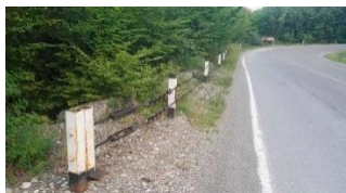
Рисунок 1.2 -Тросовые дорожные ограждения 1960-70-х. г.
